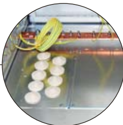
Дно шкафа с сальниками для подвода кабелей снизу
