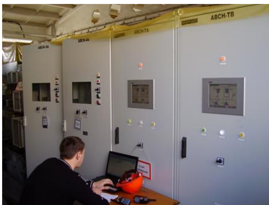
Рис. 4.27.3 – Наладка системы выделения станций на сбалансированный энергорайон на Омской ТЭЦ-4.
