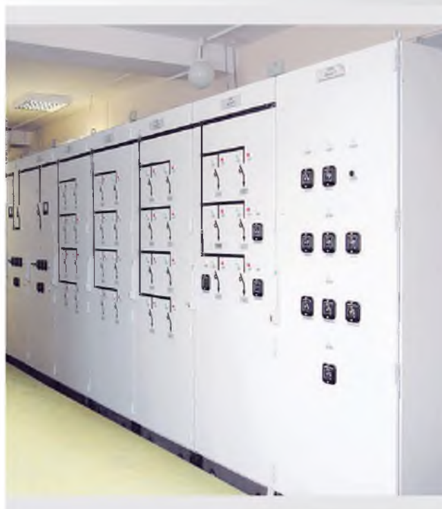
ЩСН на основе металлоконструкций Rittal и коммутационного оборудования Schneider Electric
