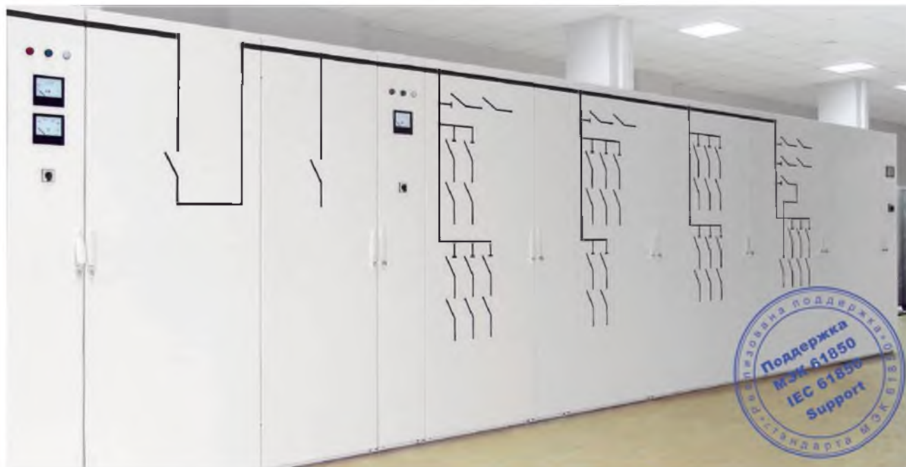
Щит собственных нужд на основе металлоконструкции Prisma P
