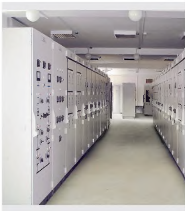
ЩСН на основе металлоконструкций Rittal и коммутационного оборудования Schneider Electric
