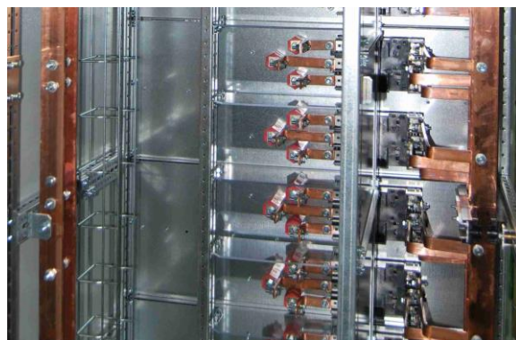
Рисунок 7.11 – Отводы из медных шин для подключения фидеров
