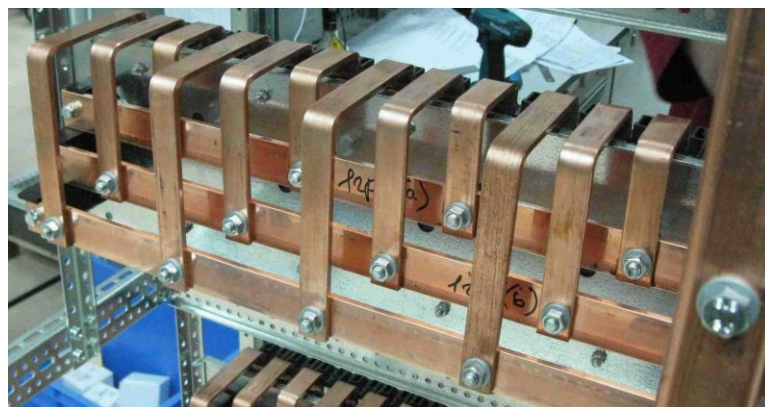
Рисунок 7.12 – Крепление сборок медных шин при помощи тарельчатых шайб DIN6796
