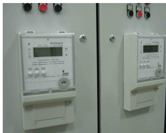
Счетчики электроэнергии
