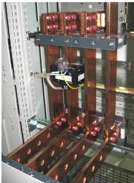
Рисунок 7.9 – Узел подключения кабелем от ТСН
