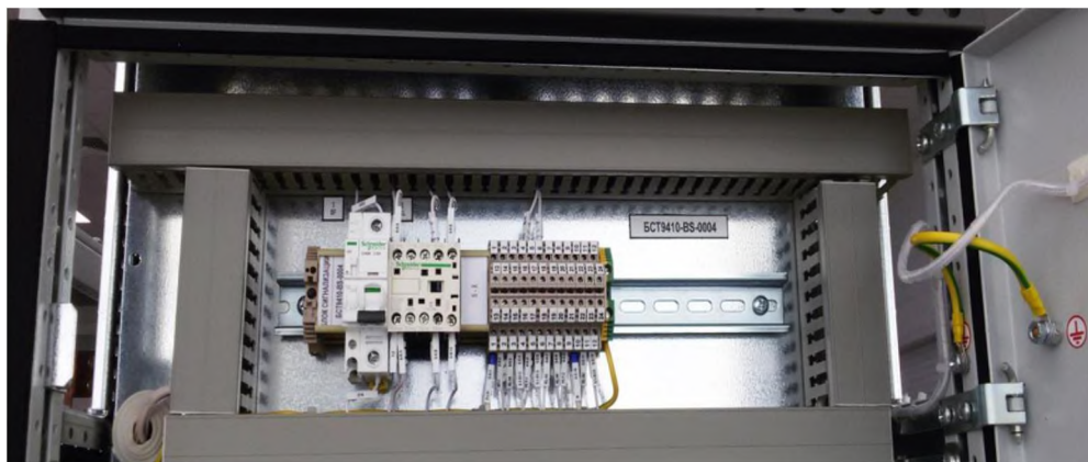
Рисунок 4.5 – Отсек общих шин
