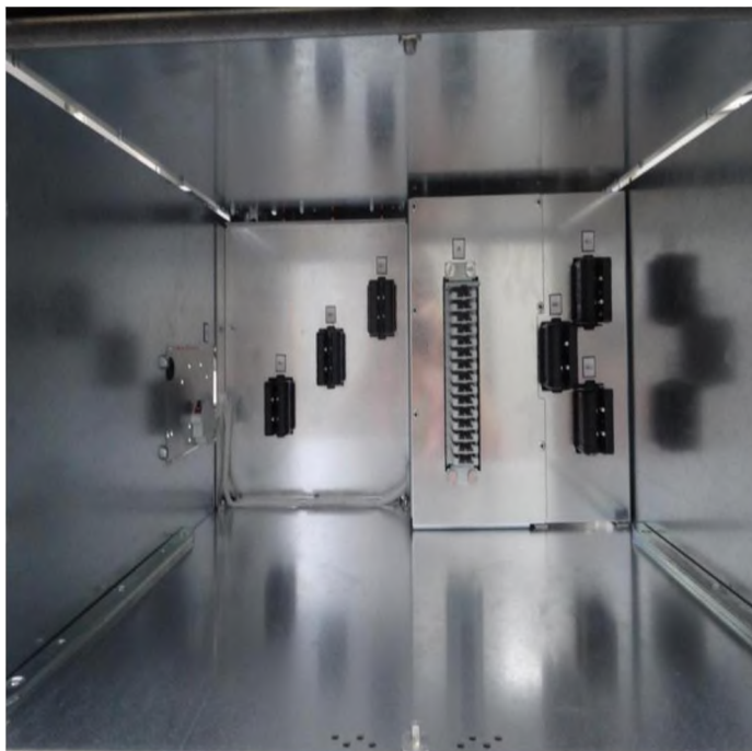
Рисунок 6.3 – Фиксированная часть блока
