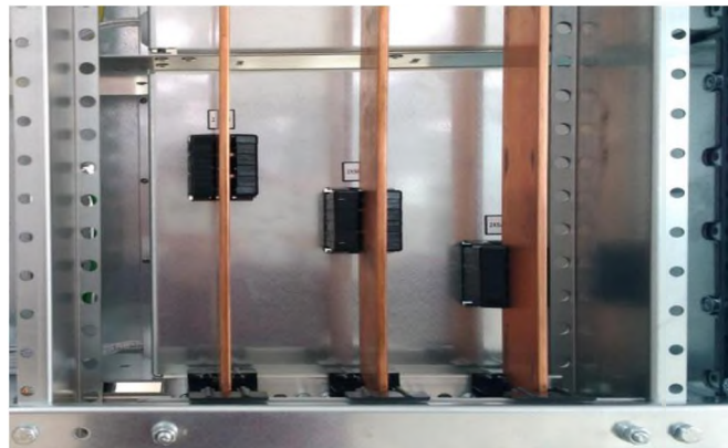
Рисунок 4.4 – Отсек вертикальных распределительных шин
