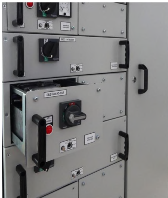
Рисунок 4.6 – Отсек функциональных блоков
